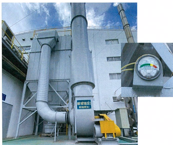
Hình 4.5. Gắn đồng hồ áp suất tại HTXL bụi
