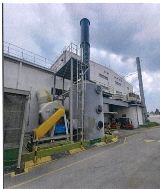
Hình 4.7. Xây gờ xung quanh HTXL khí thải, đường ống dẫn nước thải về HTXL nước thải
