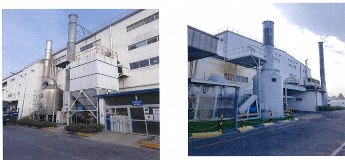
Hình 2.12. Hệ thống xử lý bụi và khí tại một số khu vực
