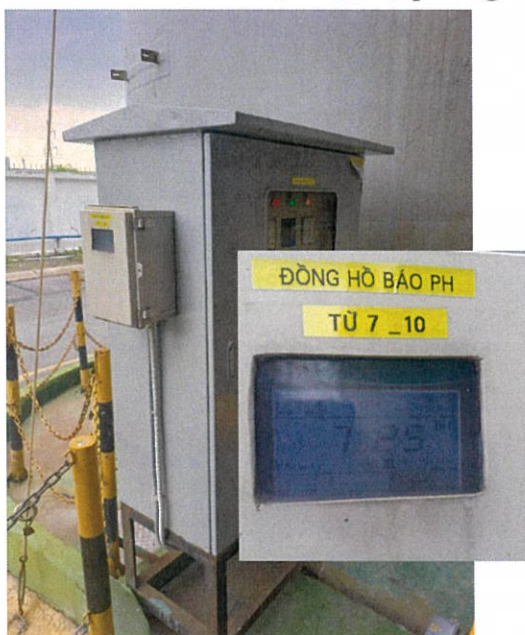
Hình 4.6. Tủ hiển thị giá trị pH tại HTXL khí thải
